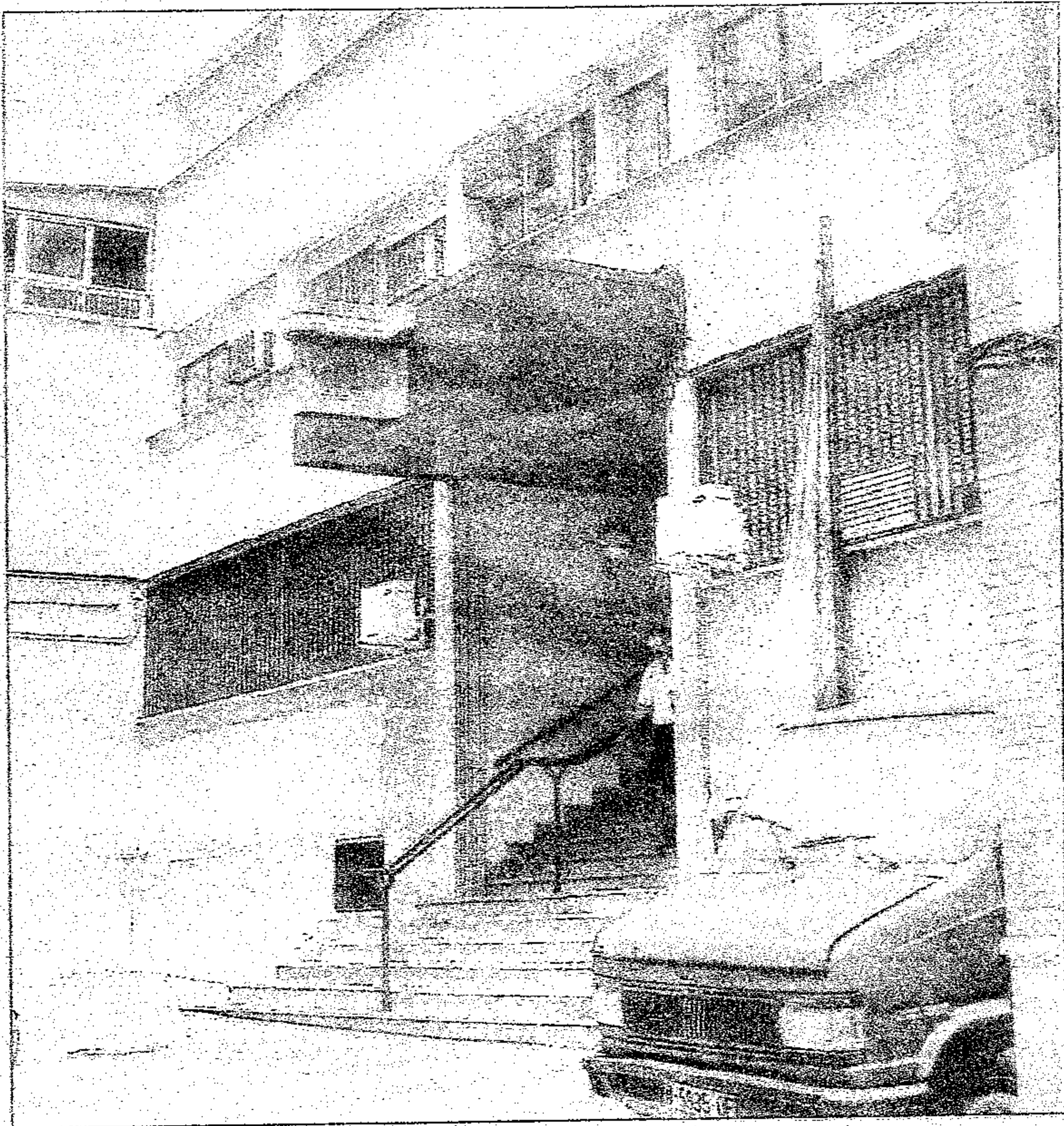
Imagen de la Comisaría de Puertollano. / PILAR G. MANZANARES
