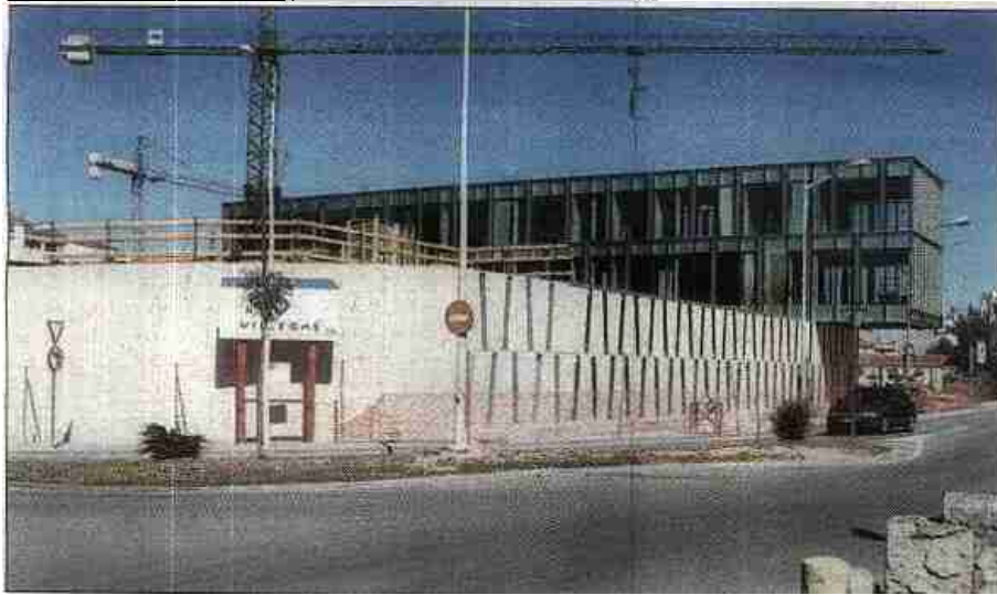
Estado actual de las obras de la Comisaría en el solar de la antigua cárcel.
